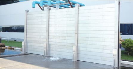
タイの生産拠点における止水壁の組み立て訓練
