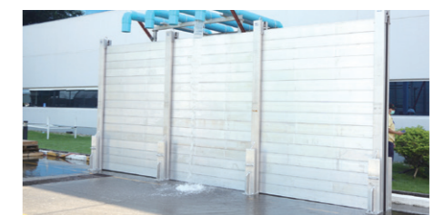
タイの生産拠点における止水壁の組み立て訓練
