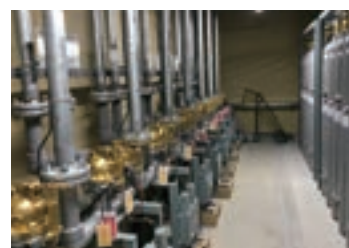
人や装置にも安全なガス消火設備
