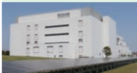
ローム浜松 太陽光発電システムの事例
