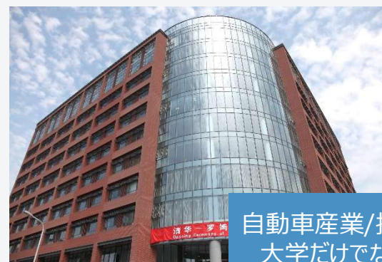
清華ローム電子工程館 (2011年4月開設)
